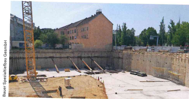
FREIGELEGT Die Mixed-in-Place-Verbauwand.
